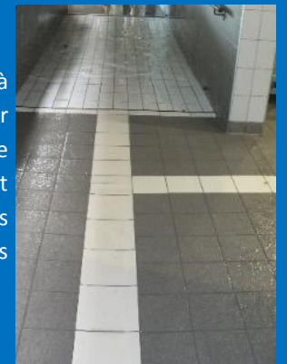
8) Illustration d'un cheminement intérieur avec ligne guide
